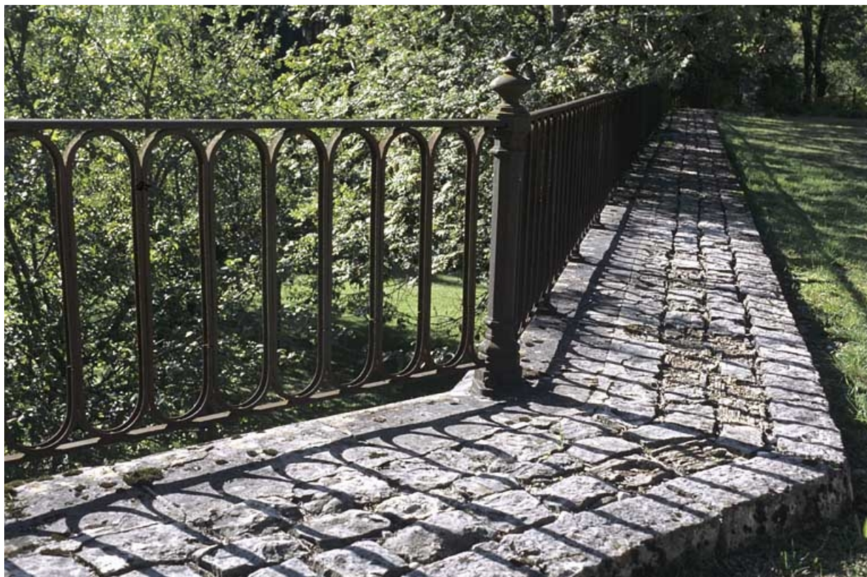
Garde-corps métallique de la cour des voyageurs.
