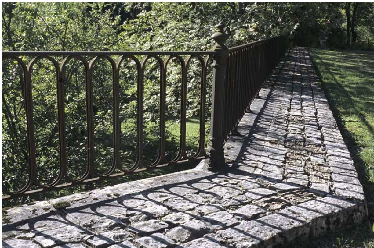
Garde-corps métallique de la cour des voyageurs.
