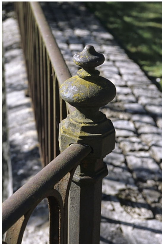
Motif d'amortissement d'un potelet du garde-corps.
