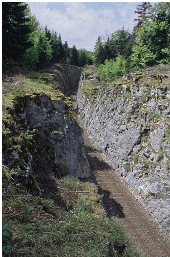
Tranchée côté Andelot-en-Montagne, vue du pont.
