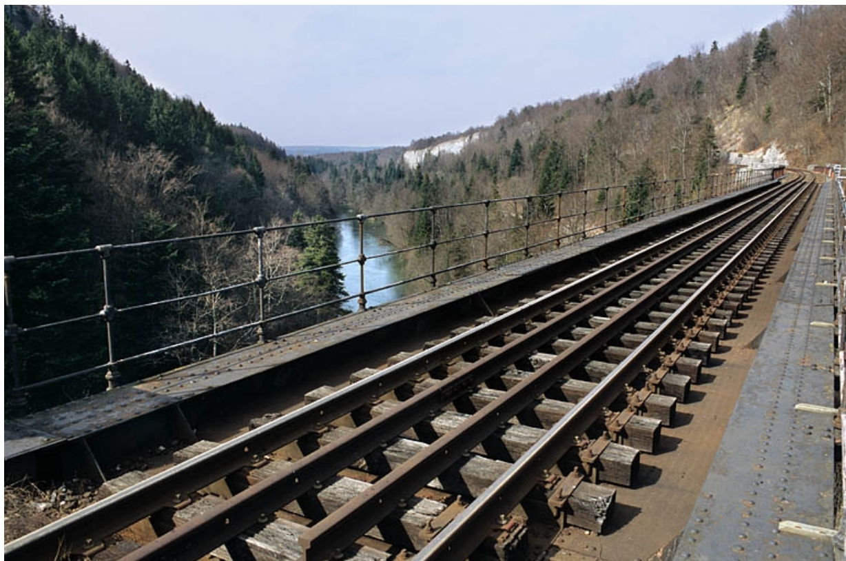
La voie sur la travée métallique, depuis le côté rive gauche (côté La Cluse).
