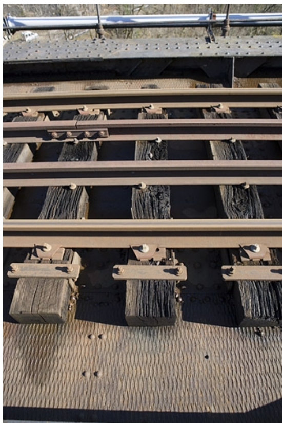
Détail de la voie sur la travée métallique.
