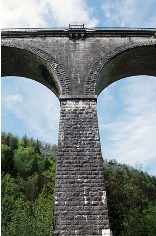
Pile en maçonnerie et refuge.
