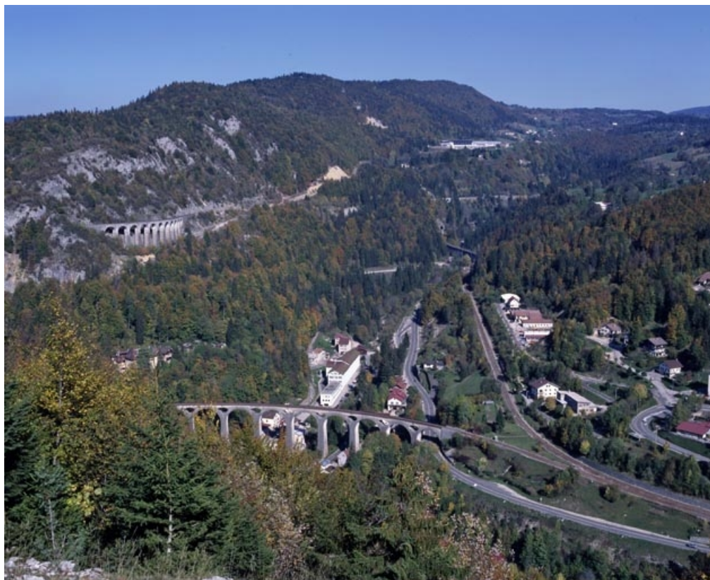
Ouvrages de Morbier et Morez, depuis le sud-ouest.
