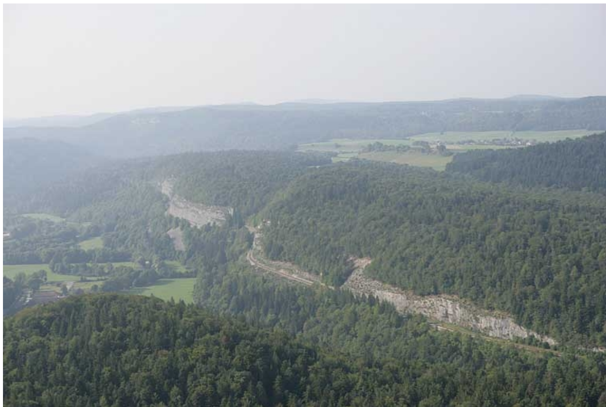
Vue aérienne de la voie à l'emplacement de la gare de Syam, depuis le nord-est.
