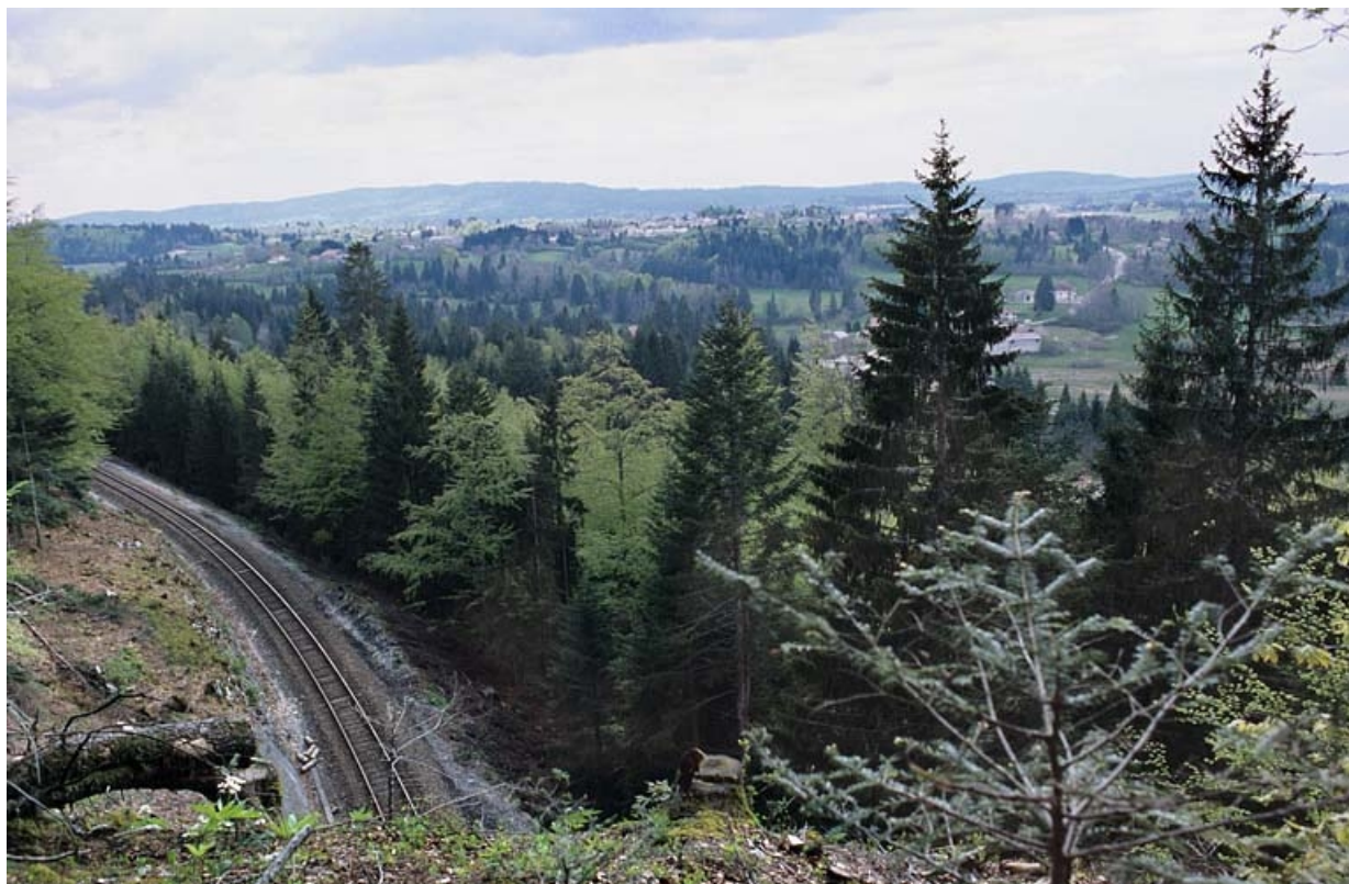
La voie vue du dessus du tunnel de la Joux (commune de Saint-Laurent-en-Grandvaux), côté Andelot-en-Montagne.
