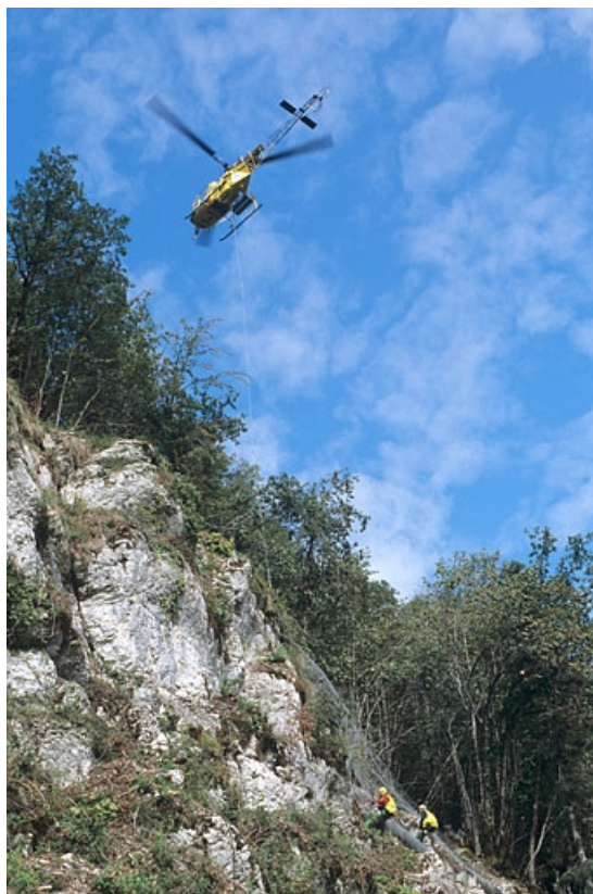
Sécurisation de paroi rocheuse à Syam : ancrage des rouleaux de filets de protection.
