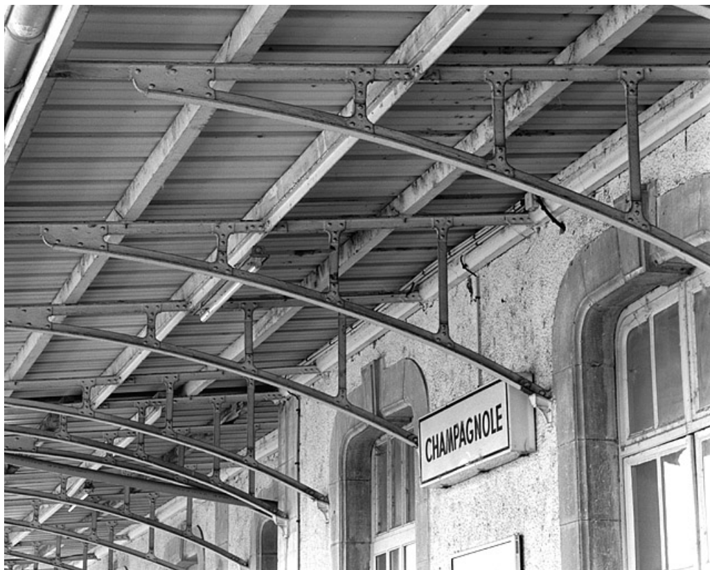
Bâtiment des voyageurs : consoles métalliques soutenant l'auvent.
