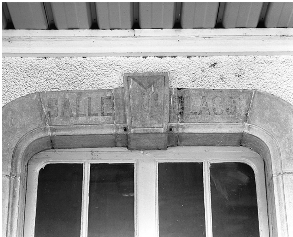
Bâtiment des voyageurs : plate-bande d'une fenêtre de la salle d'attente de troisième classe. 39, Champagne, 13 avenue de la Gare
