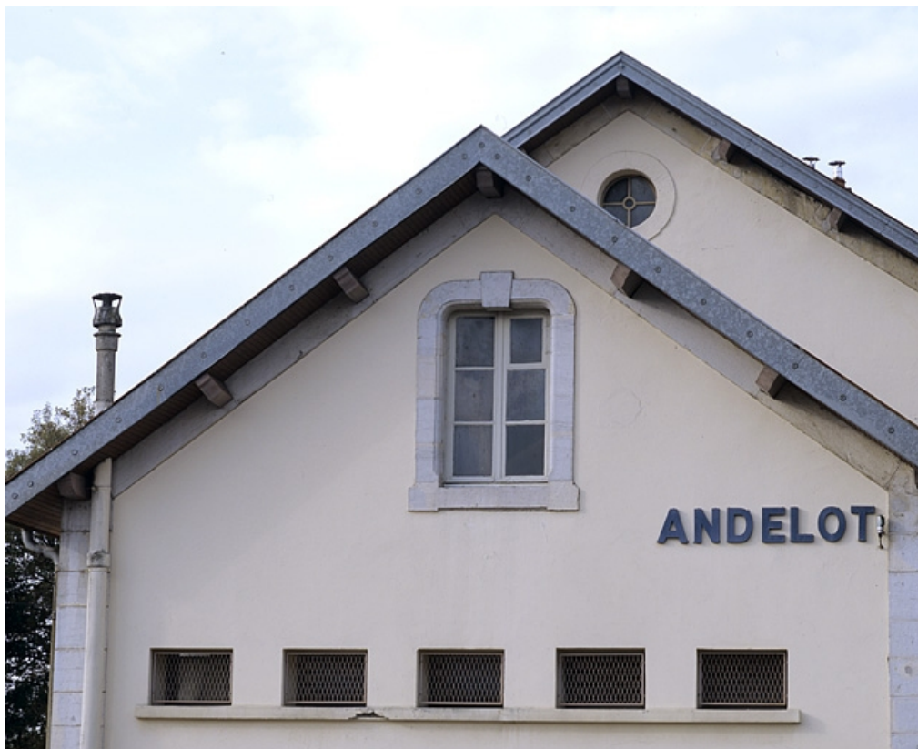
Bâtiment des voyageurs : pignon de l'aile droite.
