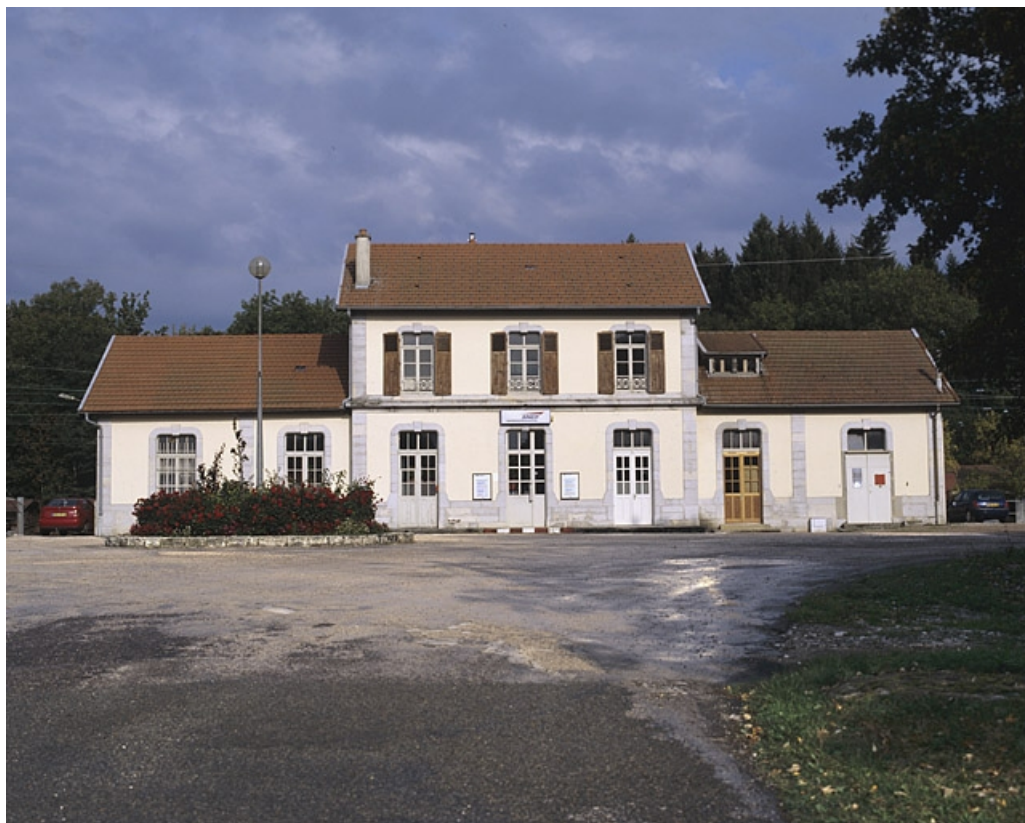
Bâtiment des voyageurs : vue d'ensemble, de face.
