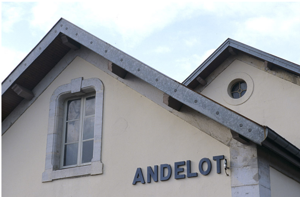
Bâtiment des voyageurs : détail du pignon de l'aile droite.
