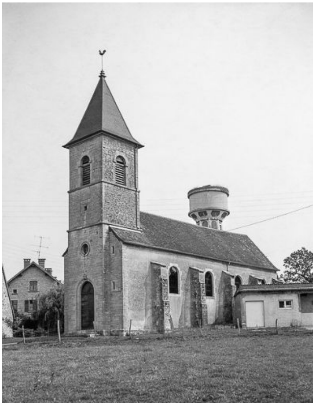
Façade antérieure et face droite.
