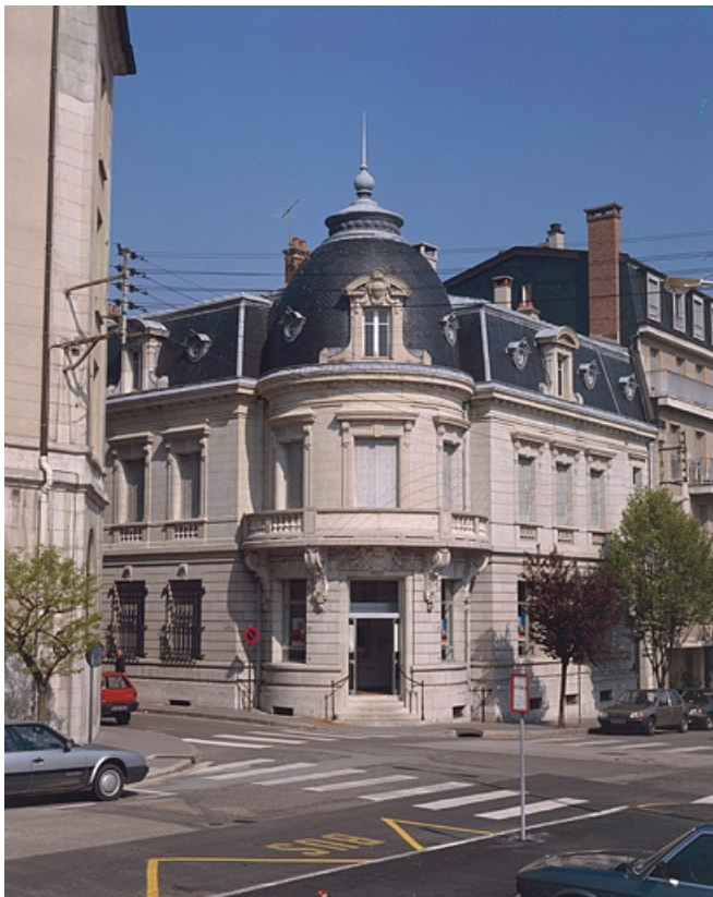
Façade antérieure. 39, Lons-le-Saunier
