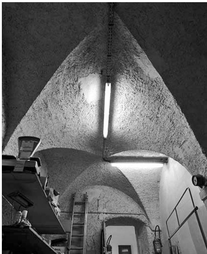
Voûtes de la pièce à gauche du hall.
