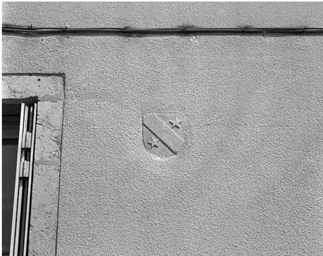
Armoiries de l'infirmier Jean François de Marnix sur la façade postérieure.
