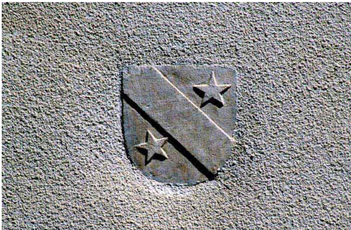
Armoiries de l'infirmier Jean François de Marnix sur la façade postérieure.
