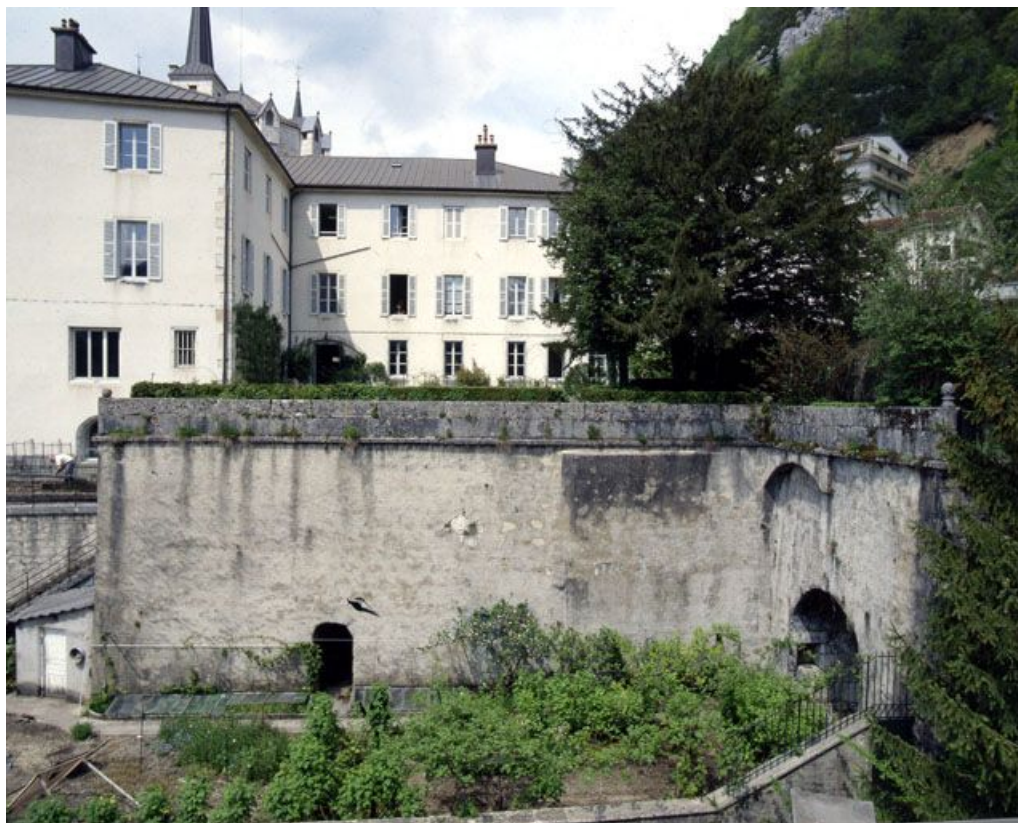
Vue générale du soubassement du jardin. 39, Saint-Claude, 2 rue de la Sous-préfecture
