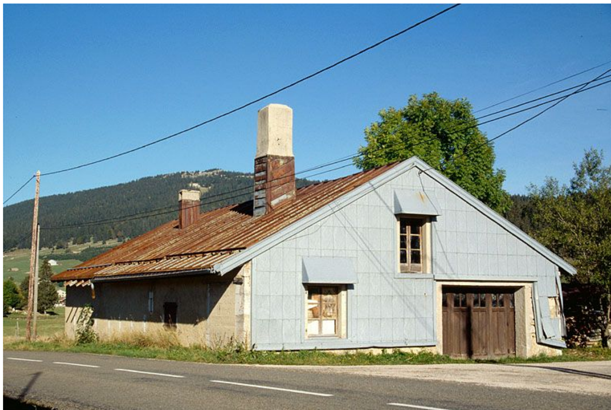
Vue générale de la fromagerie des Landes d'Aval, aux Rousses.
