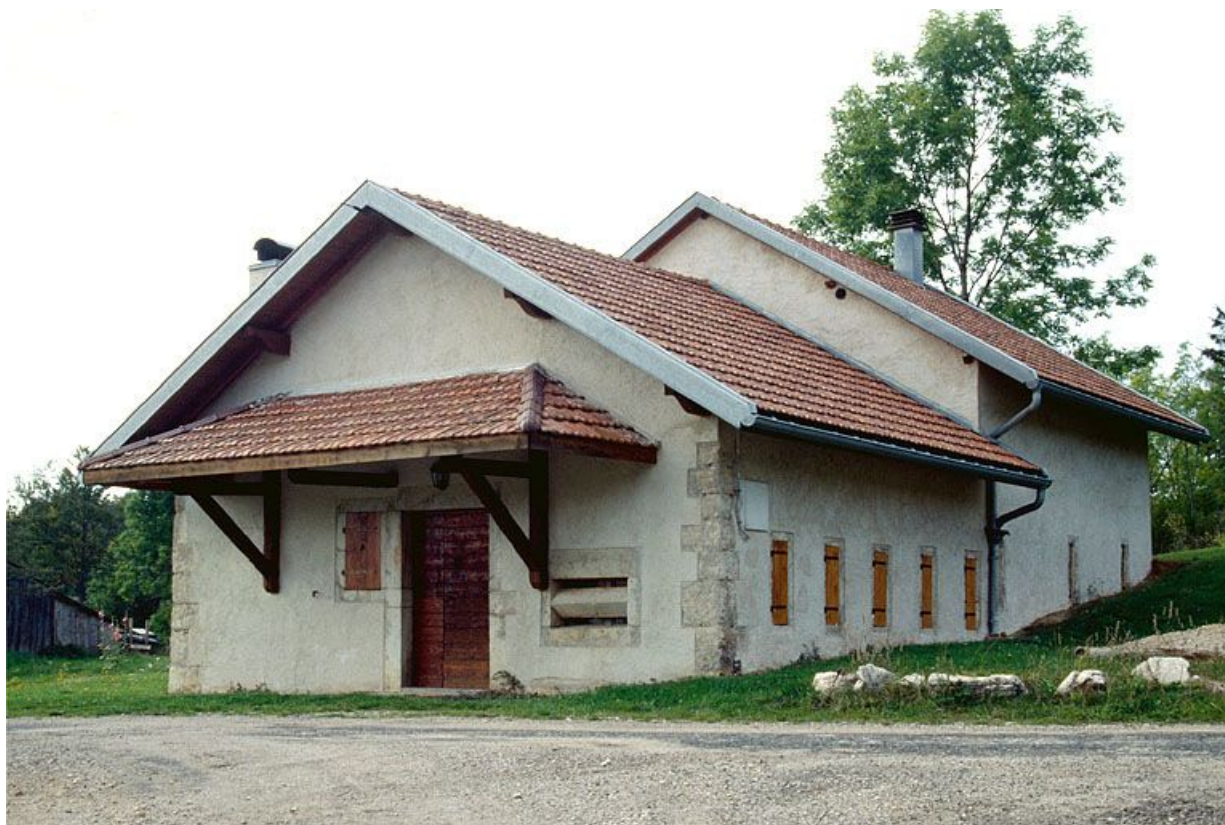
Façade antérieure de la fromagerie des Communailles, à Longchaumois, vue de trois quarts.
