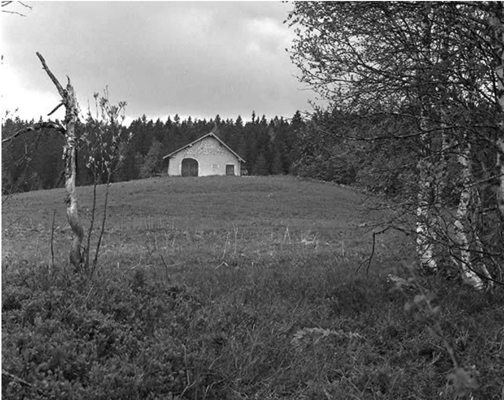
Façade antérieure, vue éloignée d'une étable à vaches. 39, Bellefontaine
