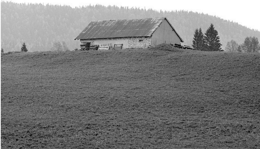
Façade postérieure et face droite d'une étable à vaches.
