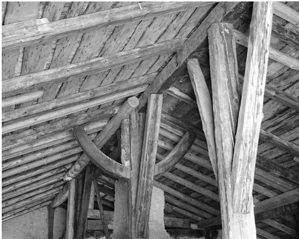
Charpente, colonne sous faîtage et contrefiche.
