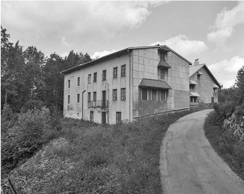
Façade postérieure et face gauche vues de trois quarts.
