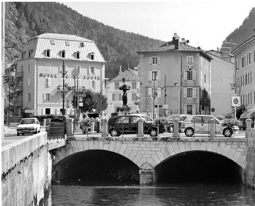
Le débouché de la Bienne, côté nord. 39, Morez place Henri Lissac
