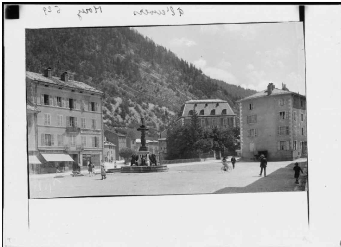
[Vue d'ensemble de la place et de la fontaine, depuis le nord-ouest], 1er quart 20e siècle. 39, Morez place Henri Lissac
