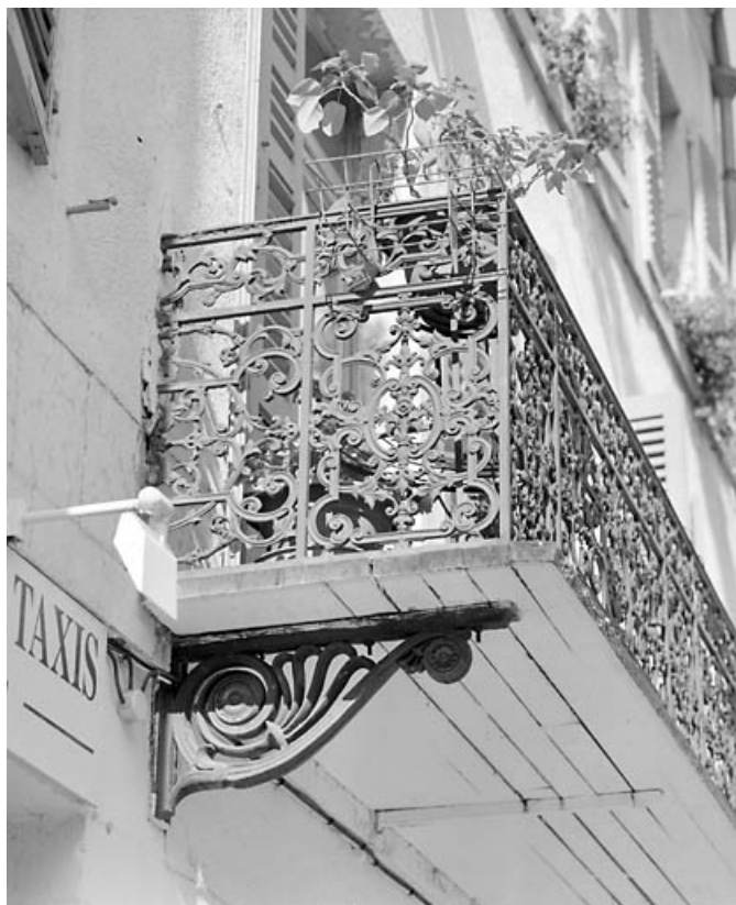
Élévation antérieure : face latérale du garde-corps du balcon.
