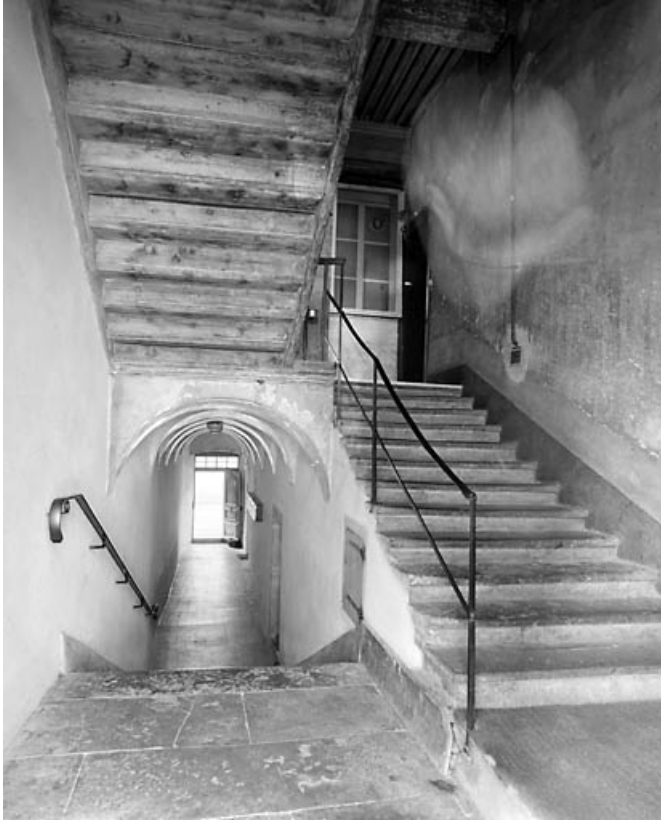
Couloir du rez-de-chaussée et escalier, depuis le premier repos. 39, Morez, 4, 6 rue Ernest Merlin
