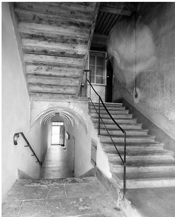
Couloir du rez-de-chaussée et escalier, depuis le premier repos.
