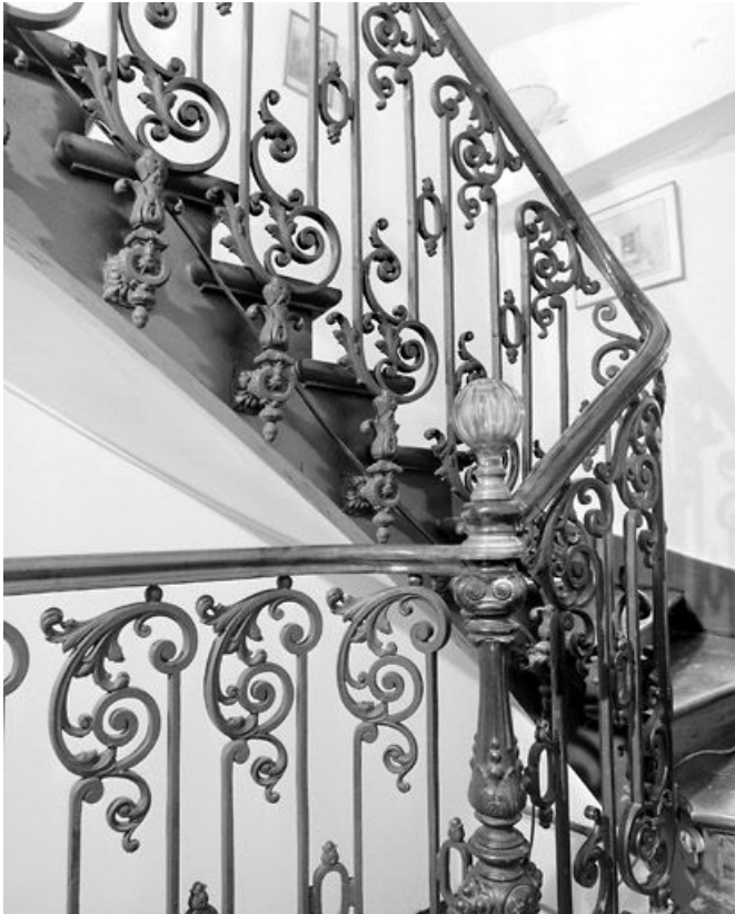
Escalier tournant : détail du garde-corps.
