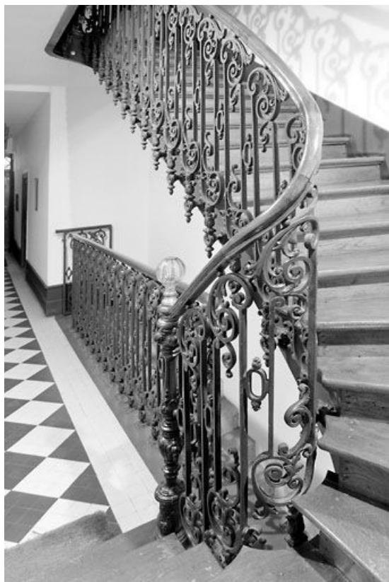
Escalier tournant, depuis l'extrémité du couloir.
