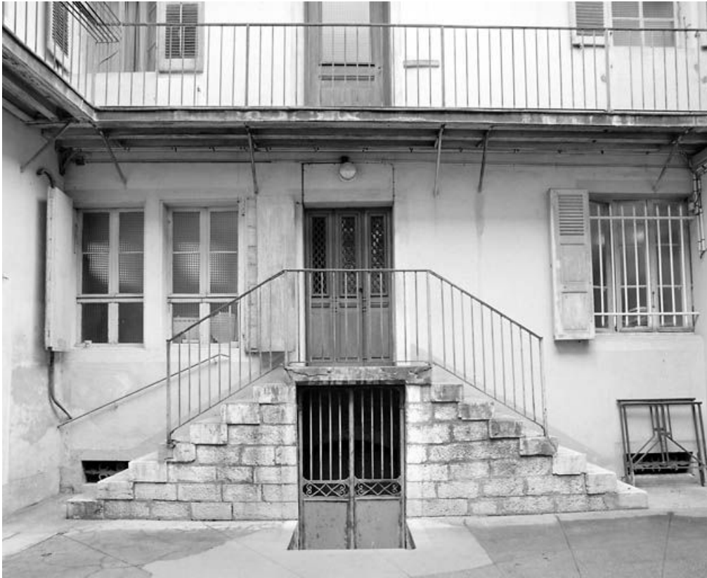
Façade postérieure : rez-de-chaussée surélevé et escalier extérieur.
