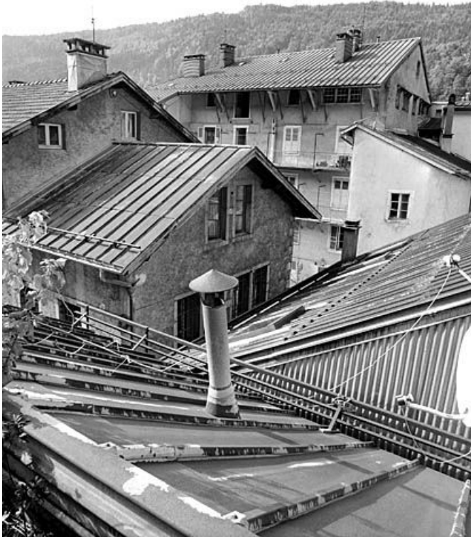
Toitures des bâtiments est et nord-est. 39, Morez, 141-143 rue de la République
