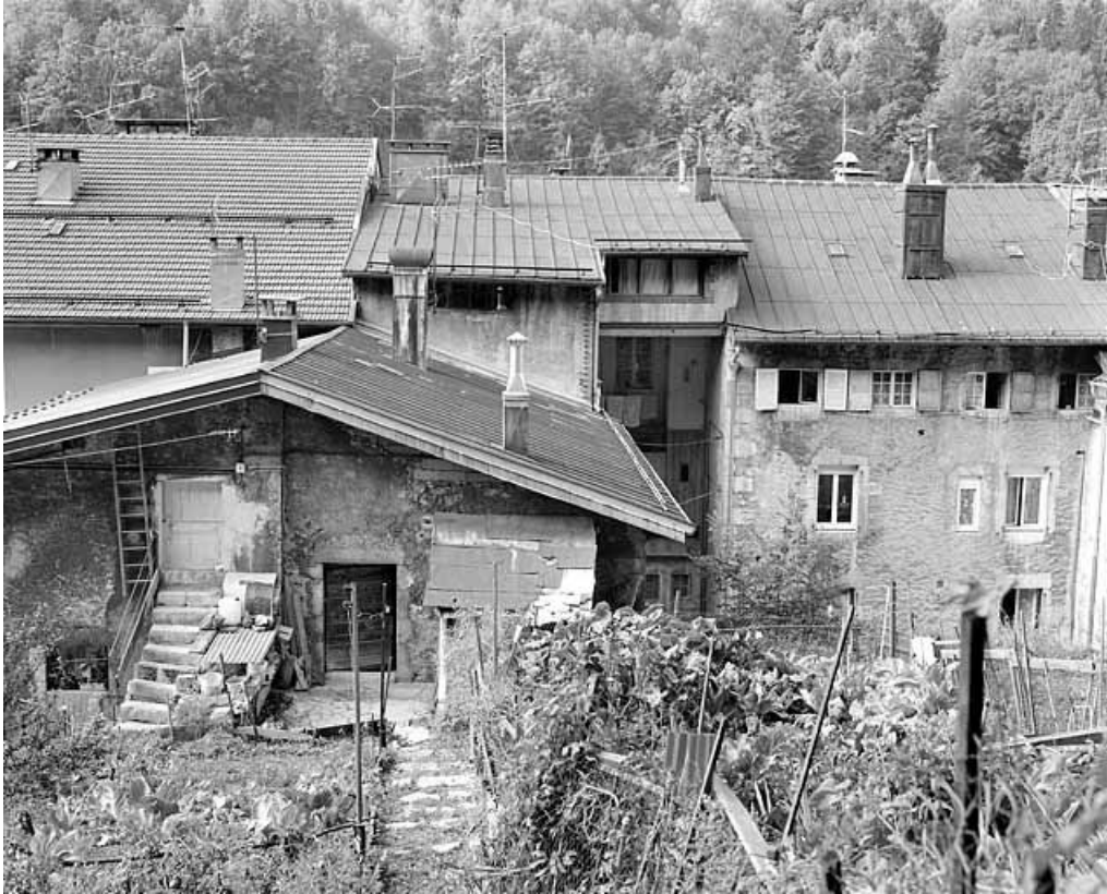
Ancien atelier : mur pignon oriental.
