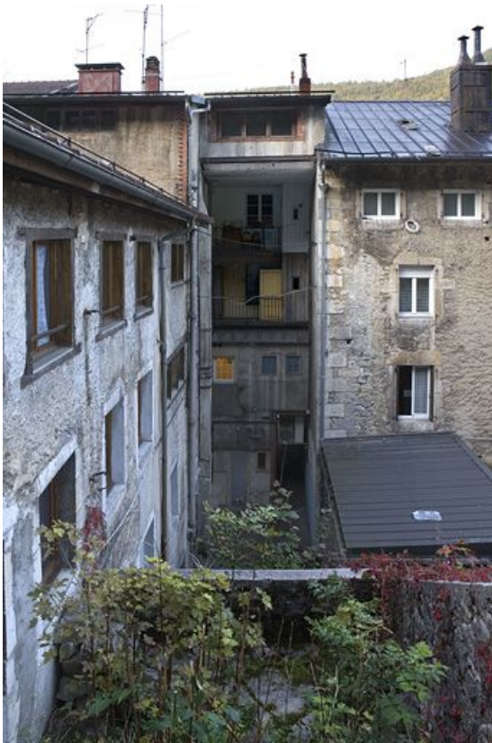
Façade postérieure, depuis le nord-est.
