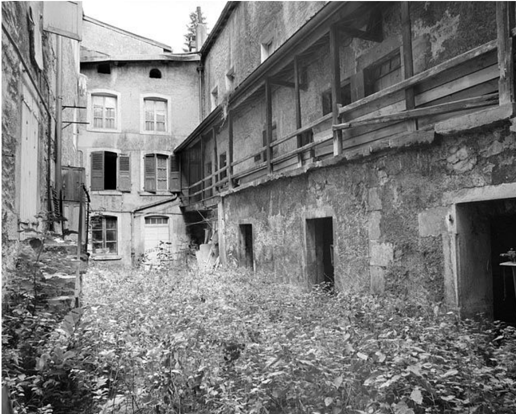
Cour à l'arrière des n° 129 et 131 : atelier à droite, logements au fond.
