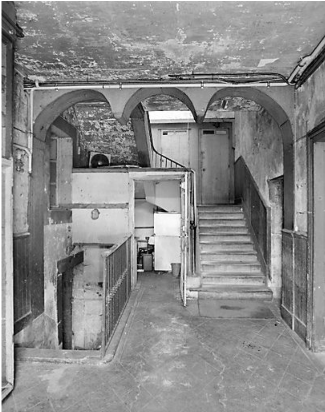
Entrée de la cage d'escalier dans la travée centrale.
