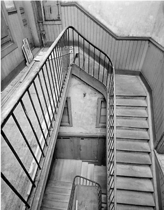
Vue plongeante sur la cage d'escalier.
