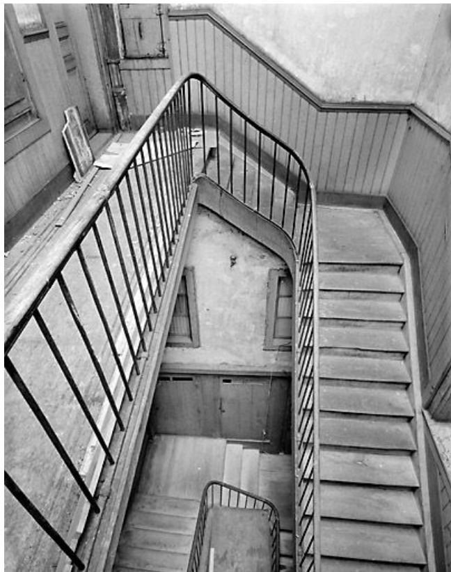
Vue plongeante sur la cage d'escalier.
