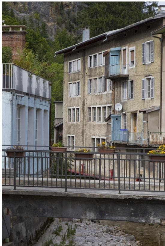
Façade postérieure de la maison et de l'atelier, depuis le sud.
