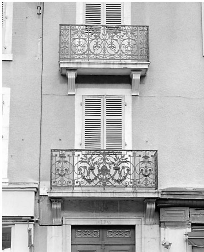
Balcons surmontant la porte d'entrée, avant restauration.
