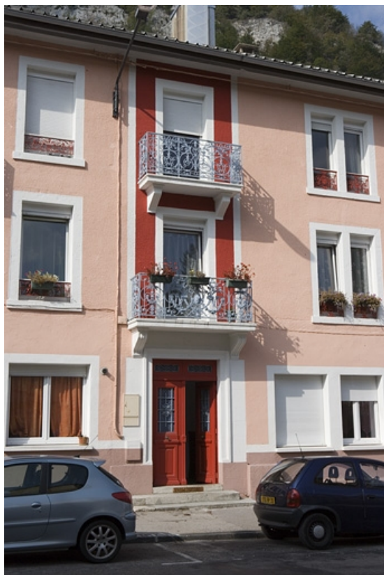
Façade antérieure : travée de la porte d'entrée.
