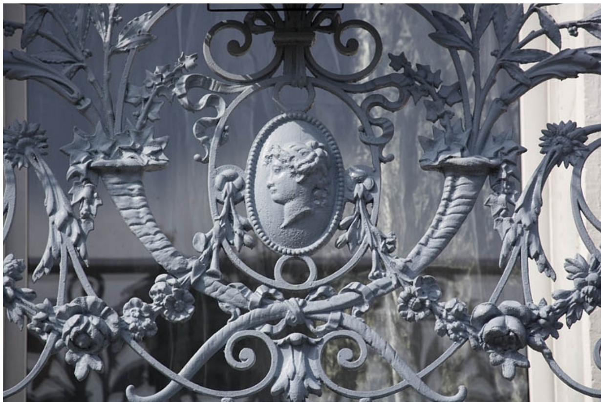
Ferronnerie du balcon du premier étage, surmontant la porte d'entrée.
