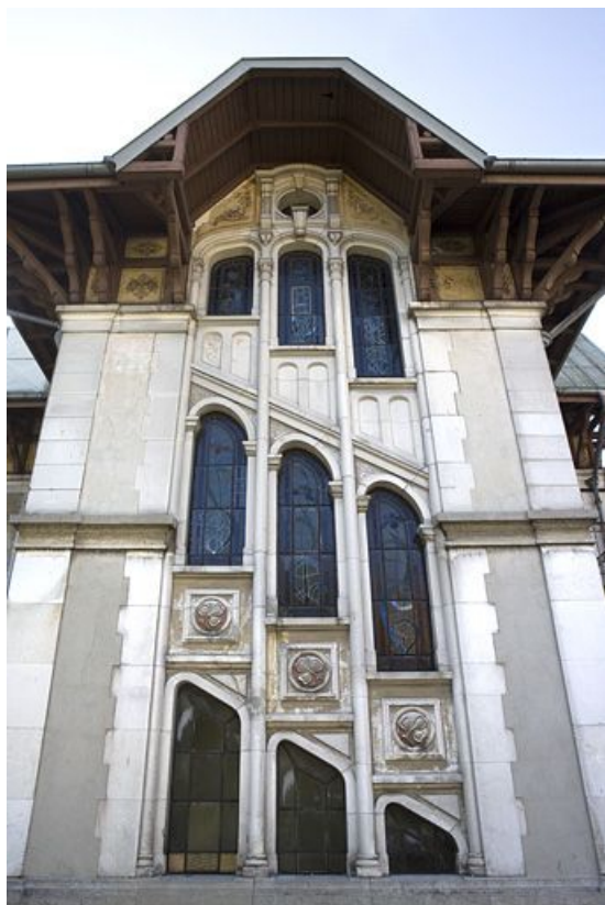
Élévation latérale gauche, en contre-plongée.
