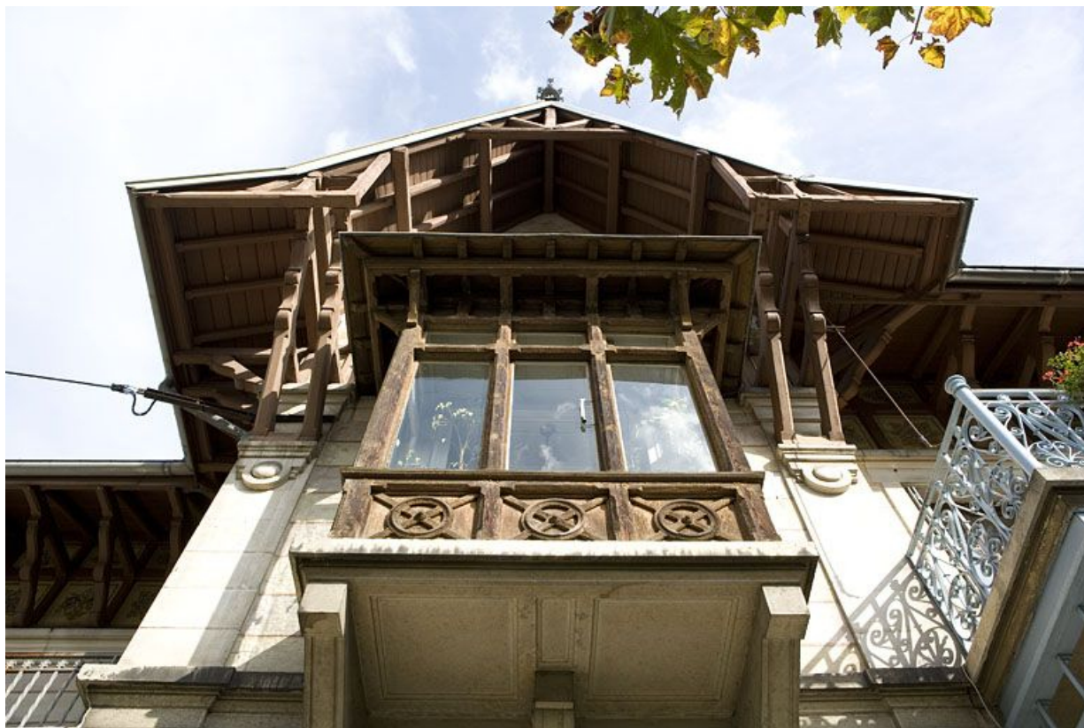
Élévation antérieure : la logette, vue en contre-plongée.
