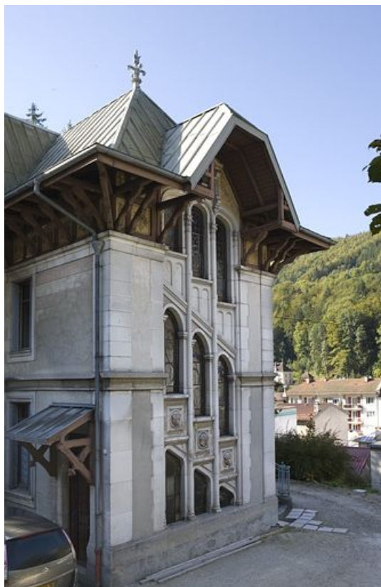
Élévation latérale gauche, de trois quarts gauche. 39, Morez, 5 avenue Charles de Gaulle
