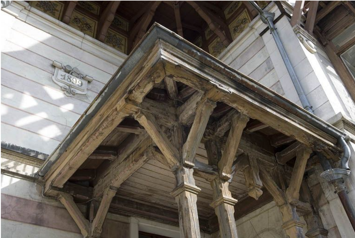
Élévation antérieure : charpente du porche.
