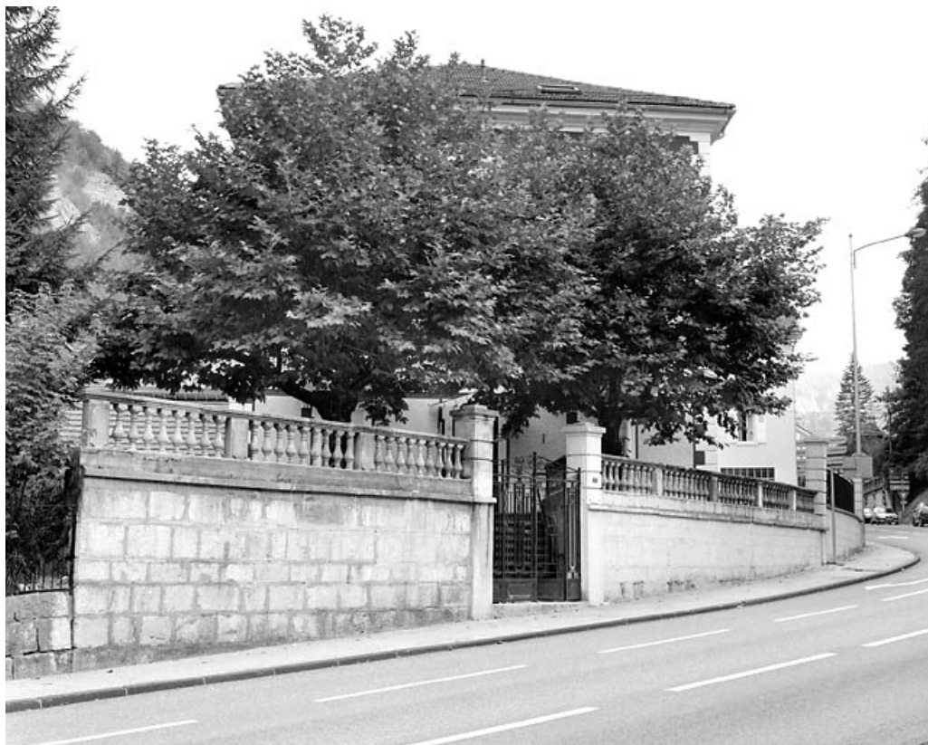
Mur de soutènement et escalier indépendant, côté rue.
