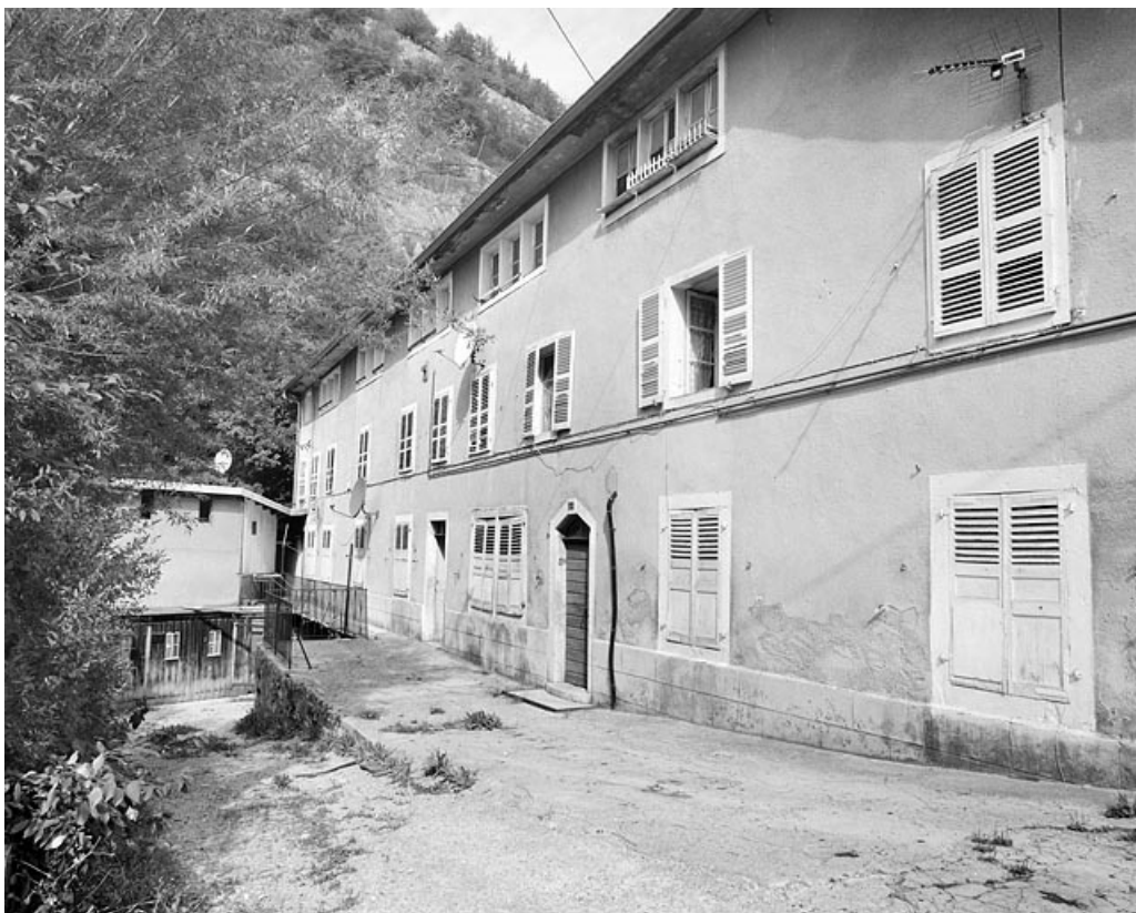
Façade principale, de trois quarts droite.
