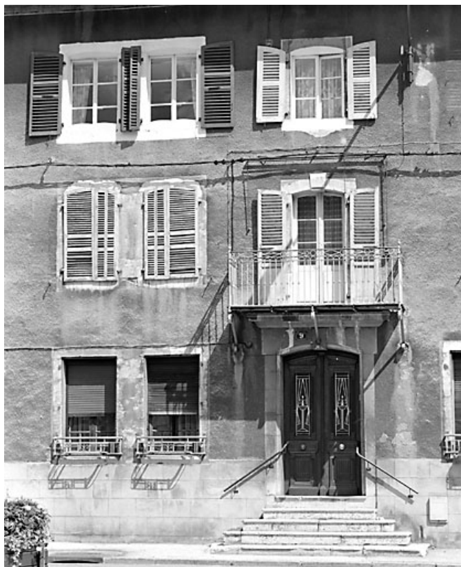
Façade antérieure : travées centrales.
