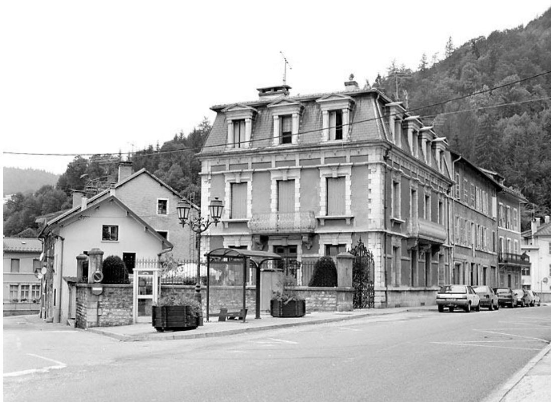
Maison de notable (1907-1908) au n° 8 rue de la République. Maison (AB 68). 39, Morez, 8 rue de la République
