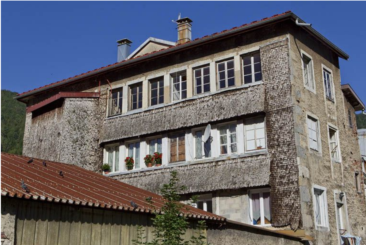
Ancien atelier de lunetterie (5 rue du Docteur Regad) : baies multiples et essentage de tavillons. 39, Morez, 5 rue du Docteur Regad
