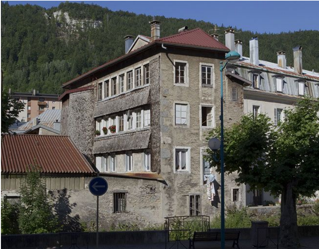
Façades postérieure et latérale droite.
