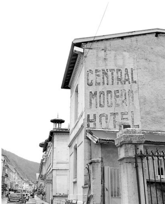
Enseigne peinte sur l'élévation latérale droite.
