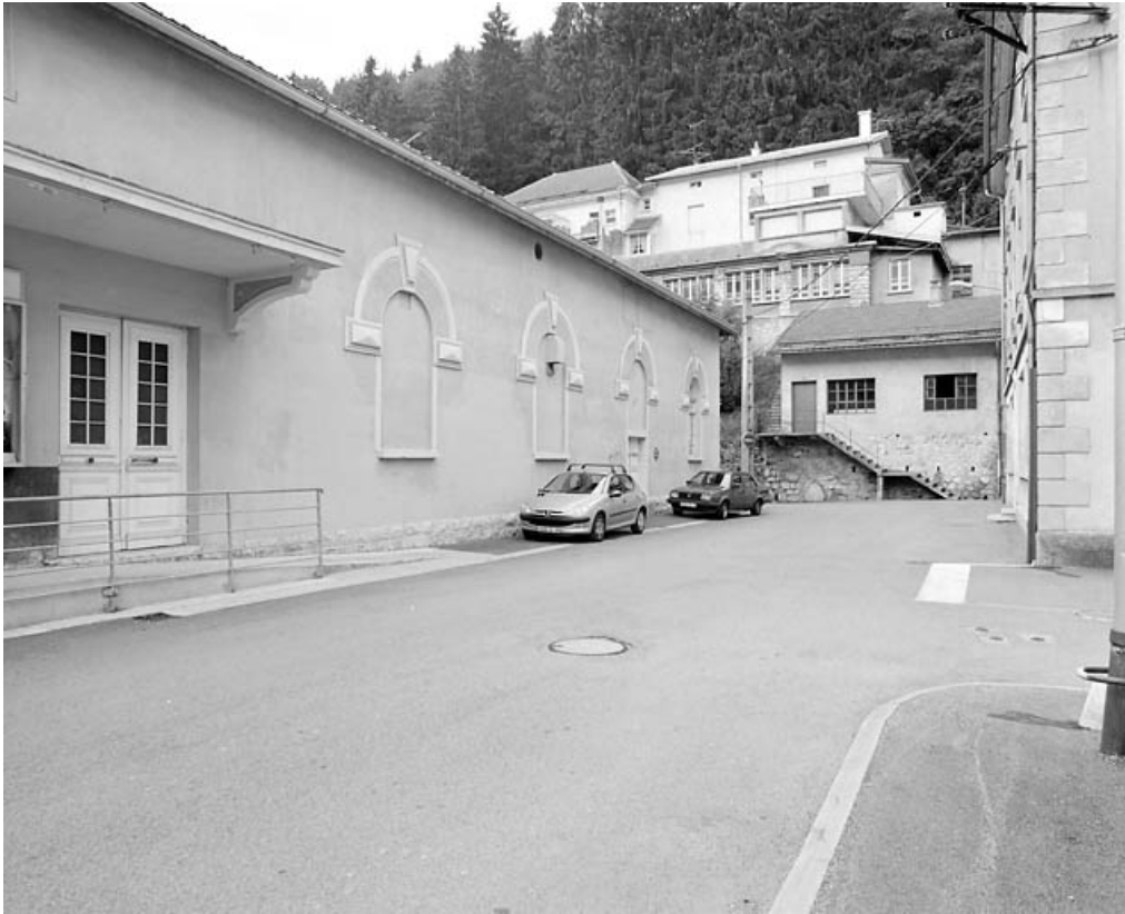
Élévation antérieure, de trois quarts gauche.
