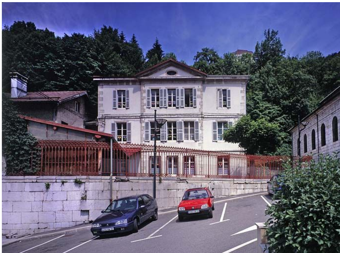
Façade antérieure. 39, Morez
