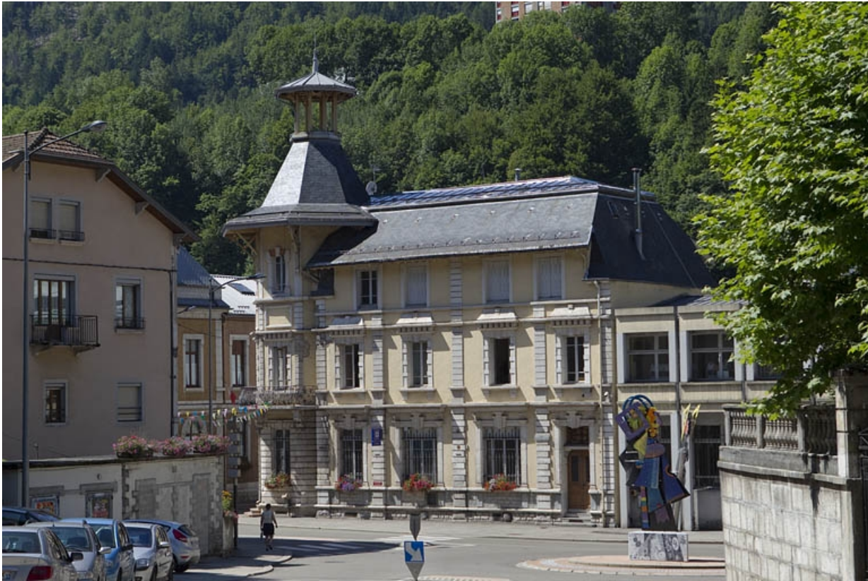
Vue d'ensemble, depuis l'avenue Charles de Gaulle (nord-est).
