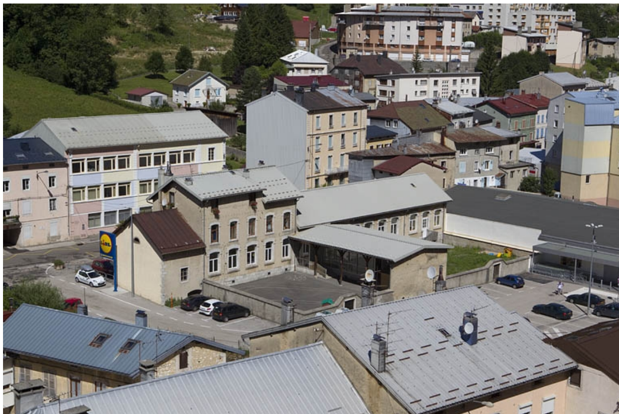
Vue d'ensemble plongeante, depuis l'est.
