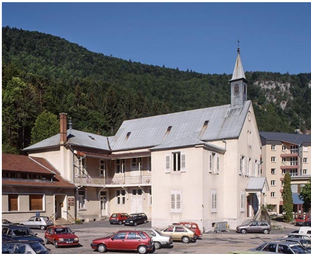
Façades antérieure et latérale gauche.
