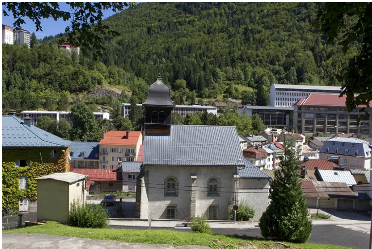
Vue d'ensemble, depuis le sud-ouest. 39, Morez, 19 rue Pasteur
