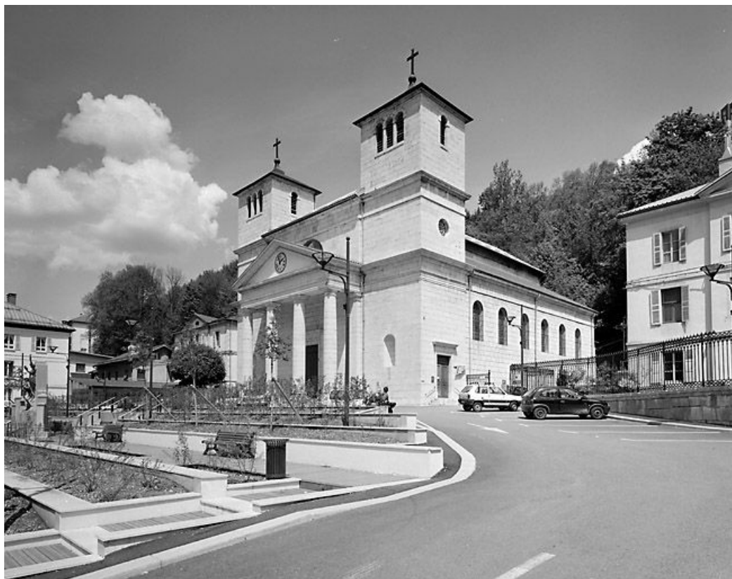
Vue d'ensemble rapprochée, côté est : église.
