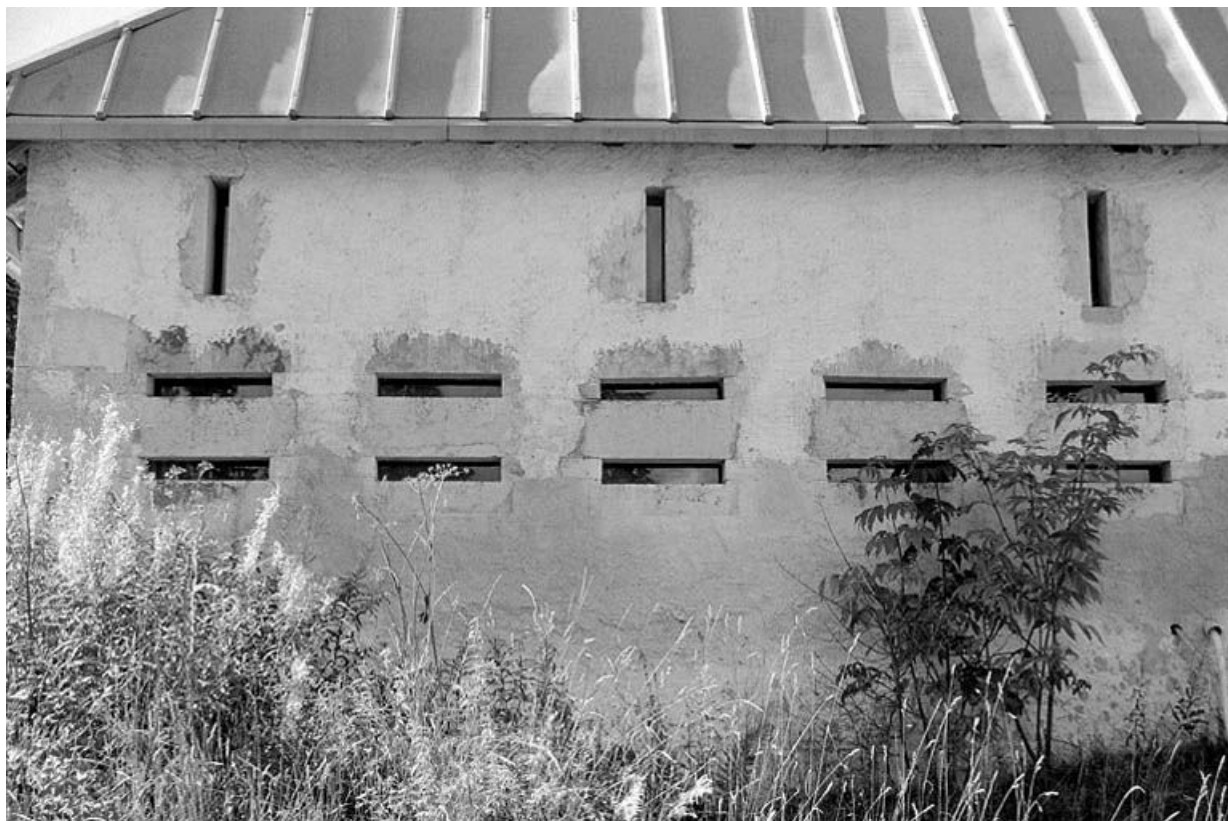
Baies fromagères sur la façade nord-est du chalet d'estive du Petit Boulu. 39, Prémaman
