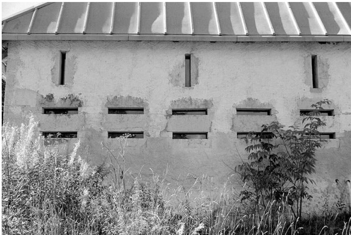
Baies fromagères sur la façade nord-est du chalet d'estive du Petit Boulu. 39, Prémanton
