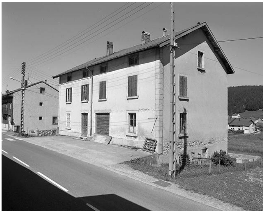
Vue de trois quarts de la façade antérieure et de la face droite.
