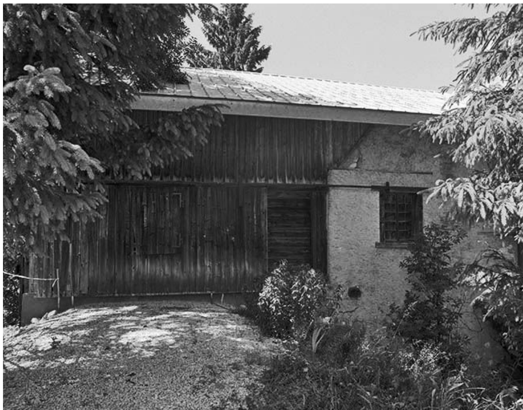
Façade antérieure du bâtiment abritant la scierie.
