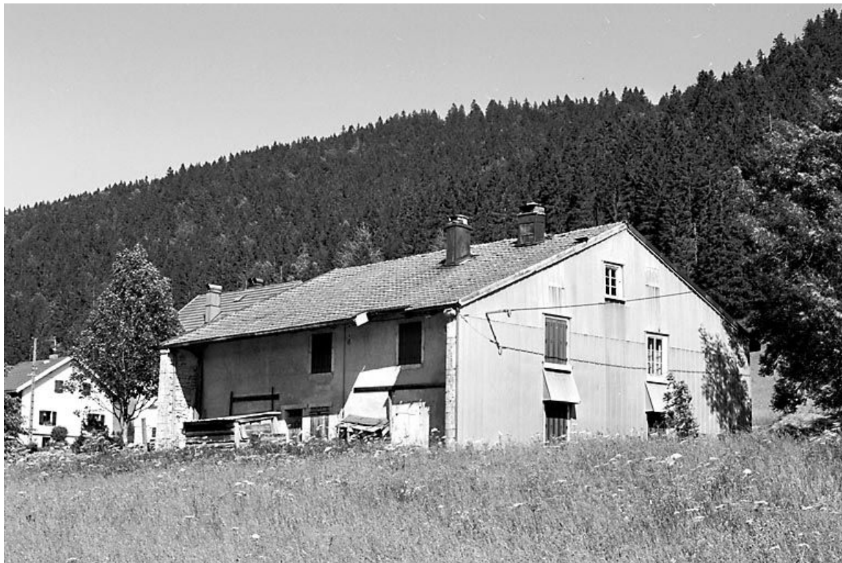
Façade antérieure et face droite.
