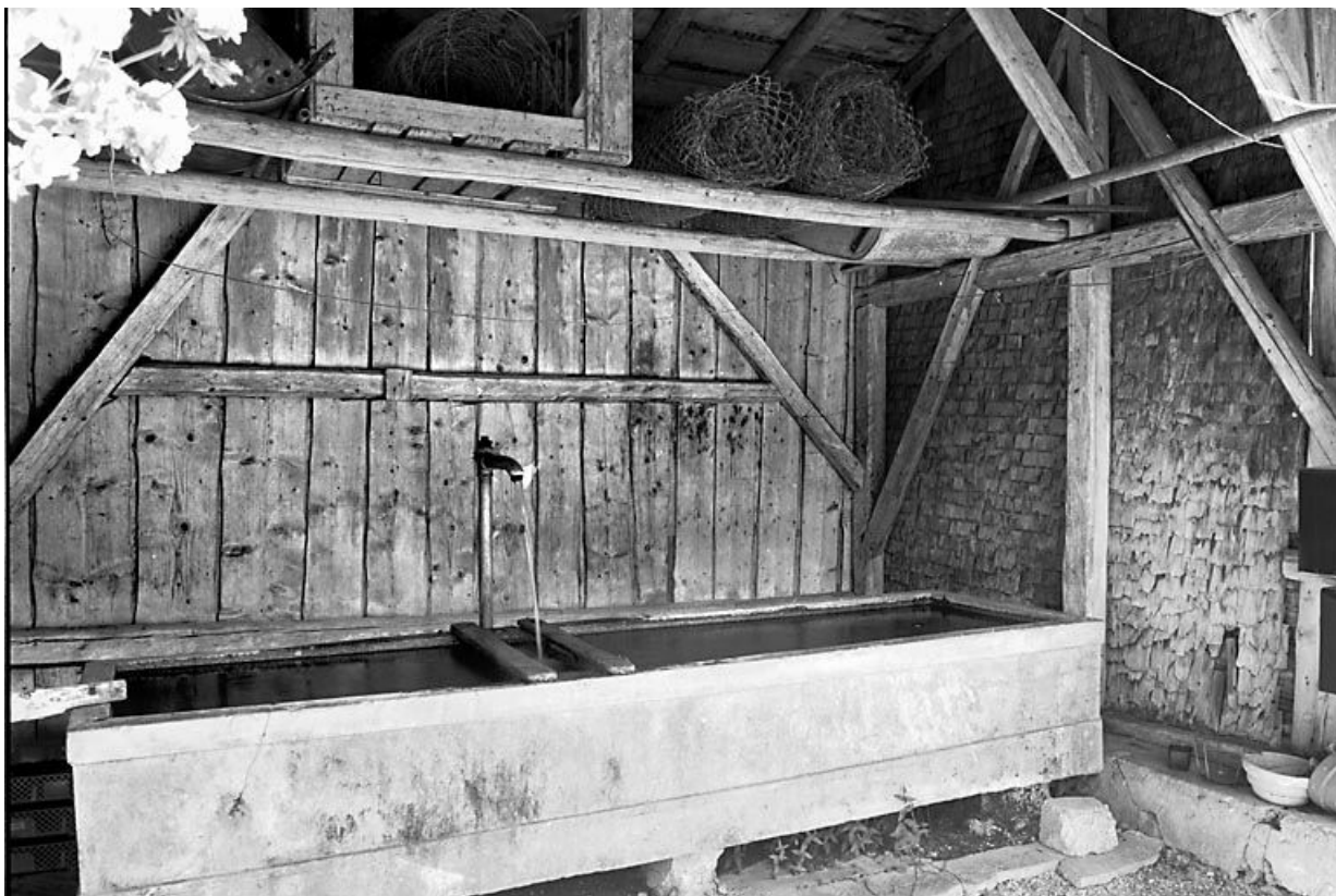
Vue du réservoir et de la charpente.
