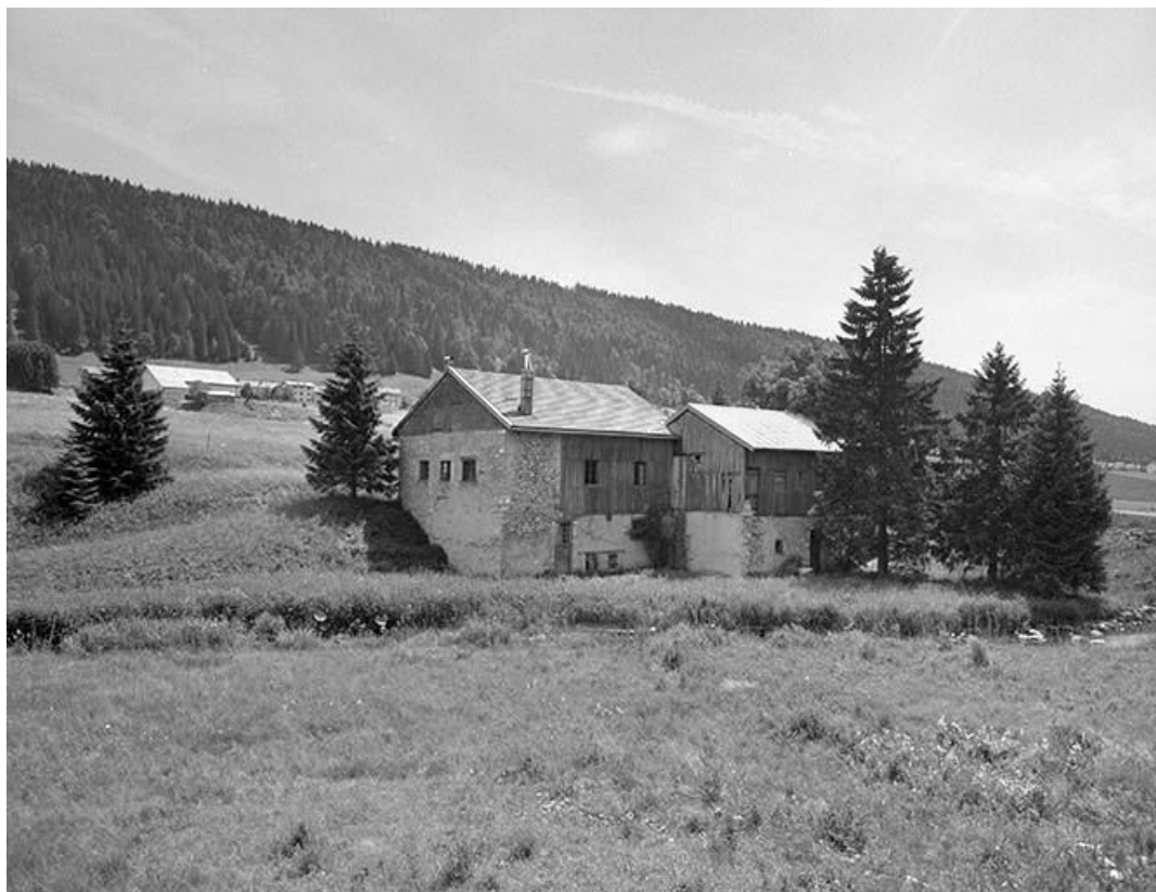
Vue de situation, façade le long de l'Orbe. 39, Bois-d'Amont
