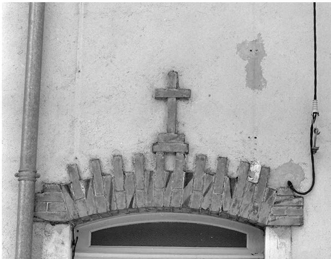
Décoration portée sur le linteau d'une porte d'accès.
