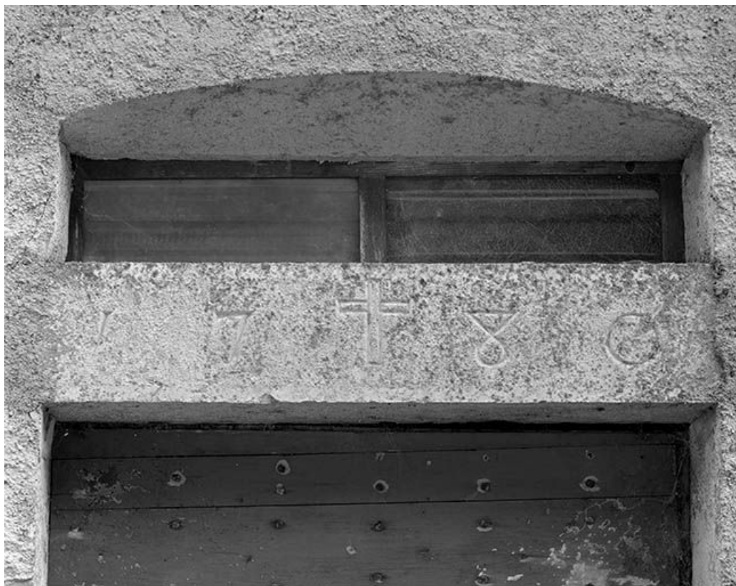
Date portée sur le linteau d'une des portes d'accès au logis.
