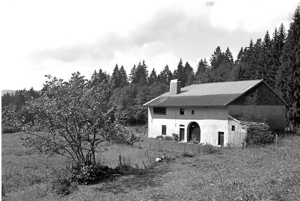
Façade sud-est, vue éloignée.
