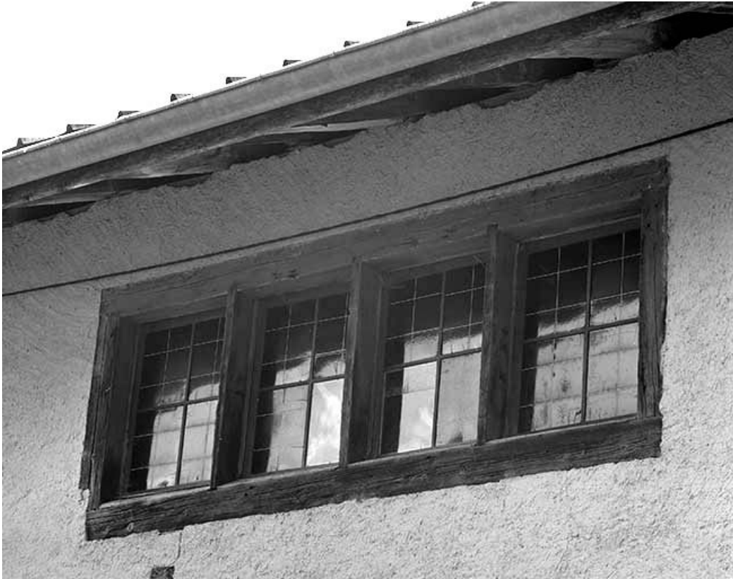
Fenêtres éclairant l'atelier ou "fenêtres de forge".
