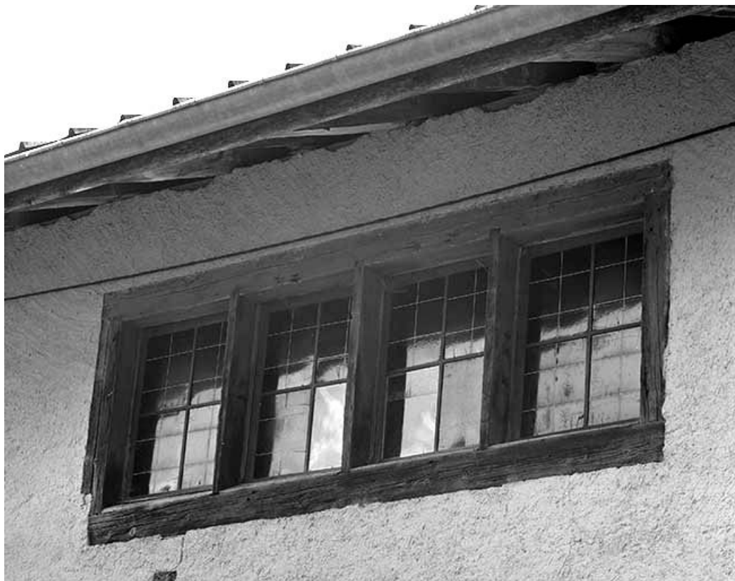
Fenêtres éclairant l'atelier ou " fenêtres de forge ".
