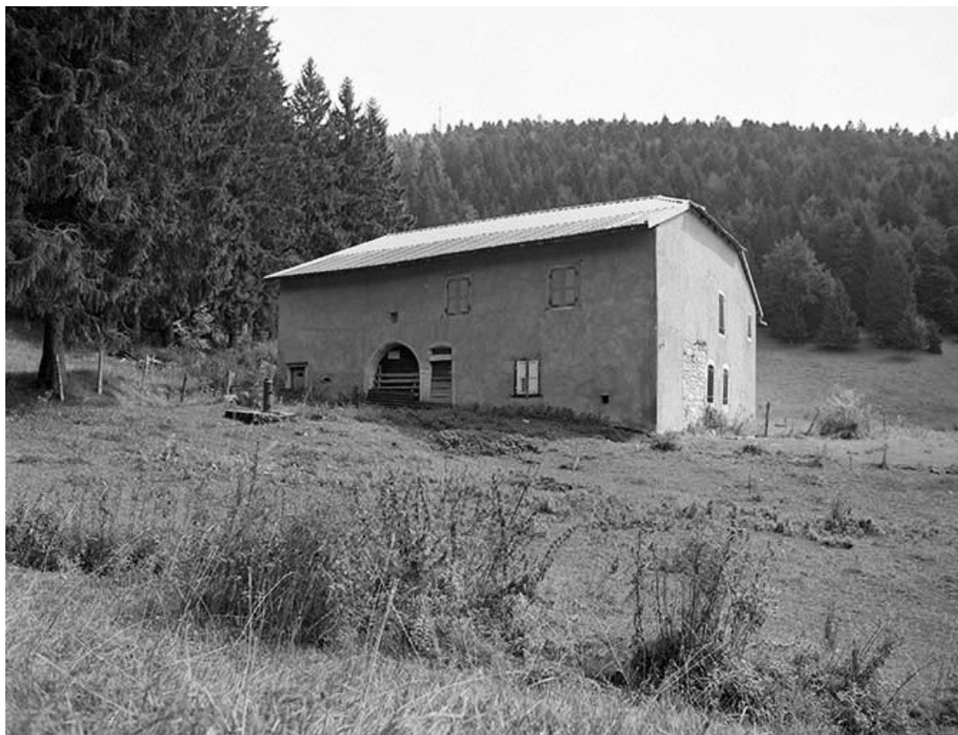
Façades nord-ouest et sud-ouest vues de trois quarts.
