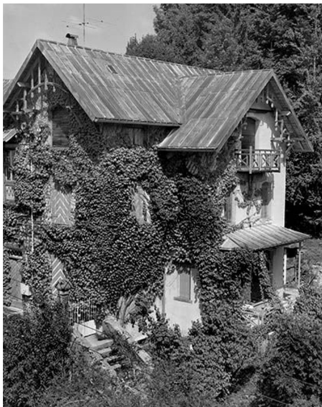
Façades sud-est et sud-ouest vues de trois quarts.
