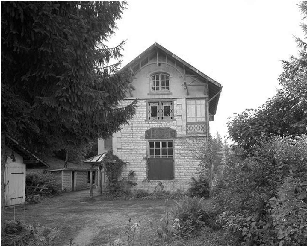
Vue générale depuis le nord-ouest.
