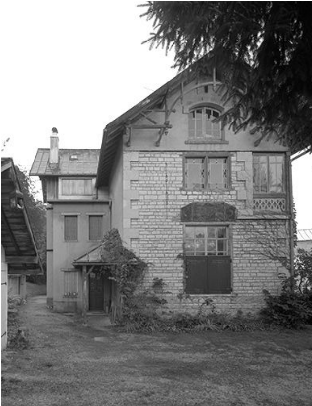
Vue de trois quarts d'une partie de la façade nord-est.
