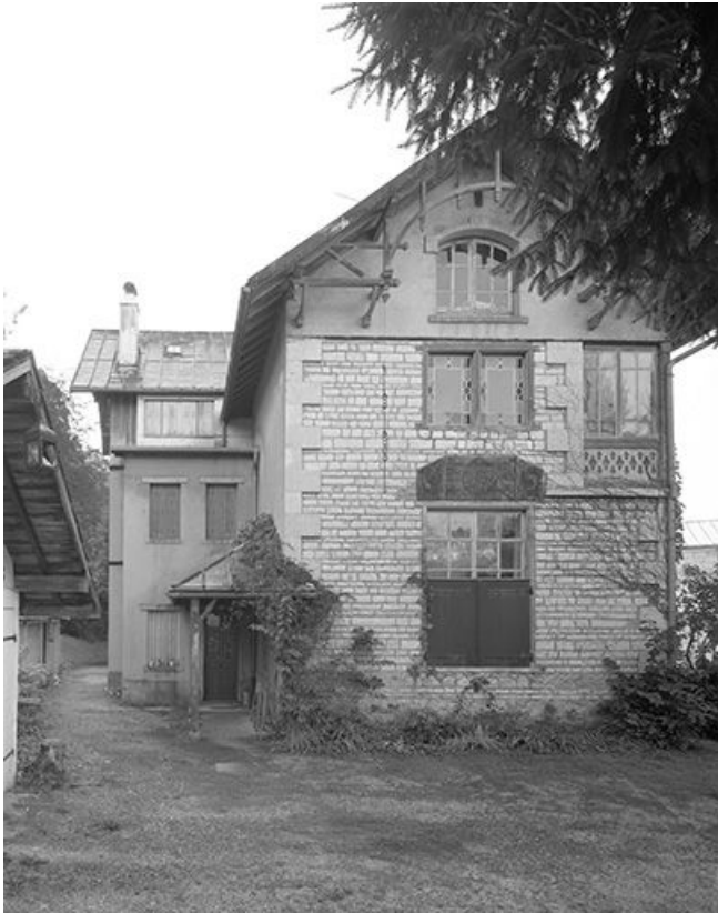
Vue rapprochée de la façade nord-ouest.
