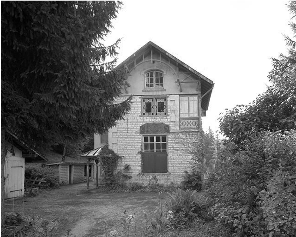
Vue générale depuis le nord-ouest.
