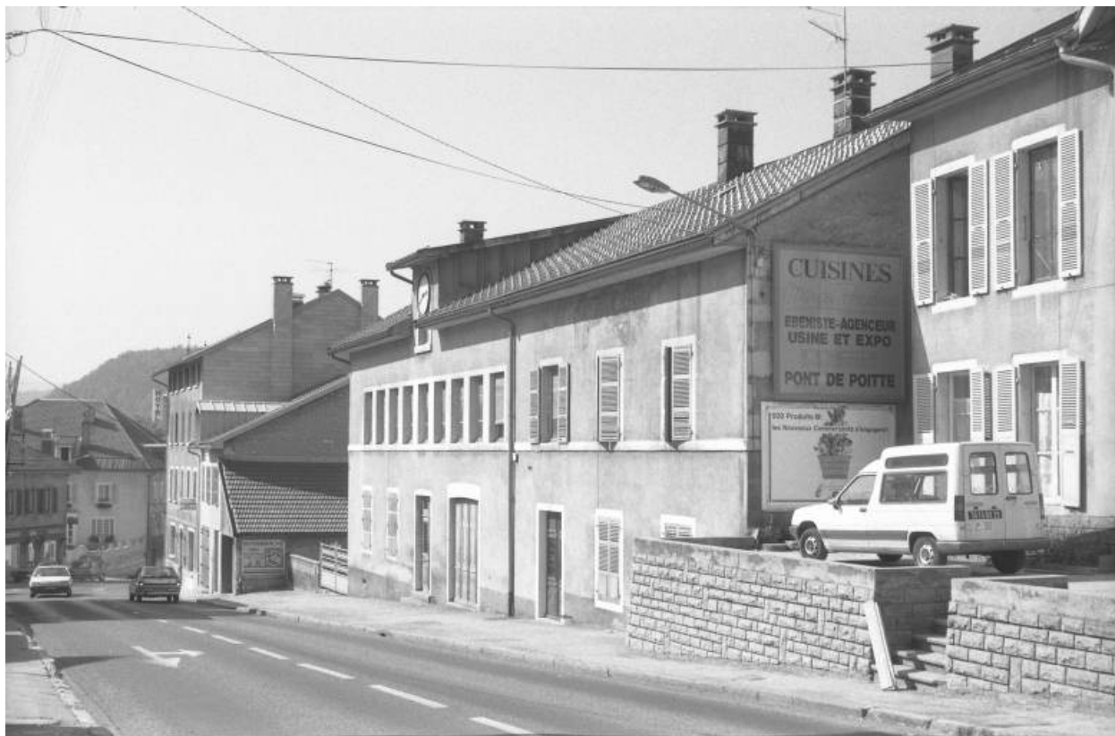
Vue d'ensemble de la façade antérieure.
