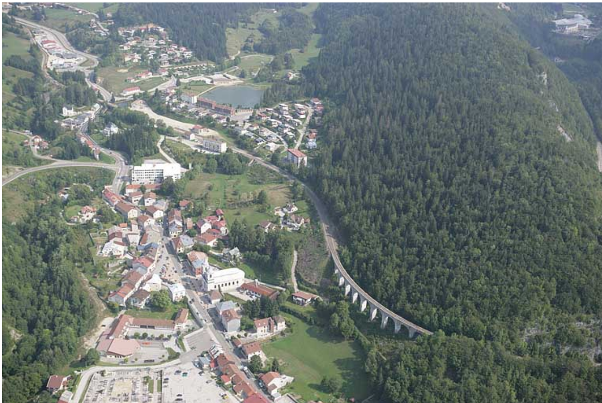
Vue aérienne, depuis le sud-ouest. 39, Morbier
