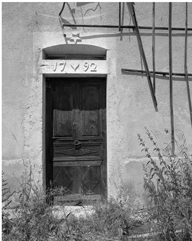
Détail des piédroits et linteau de la porte d'accès.
