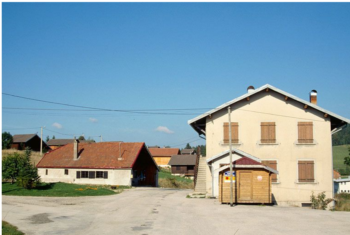
Façade sud-ouest en 1990.
