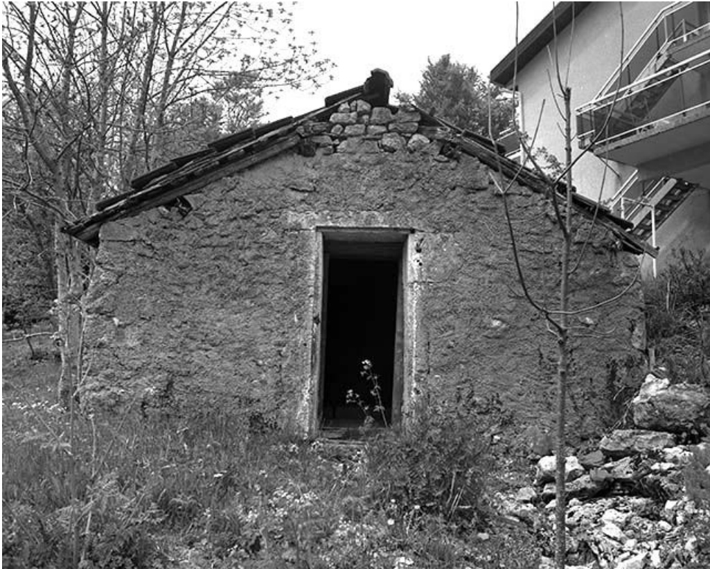
Façade antérieure de la resserre, " grenier fort ".
