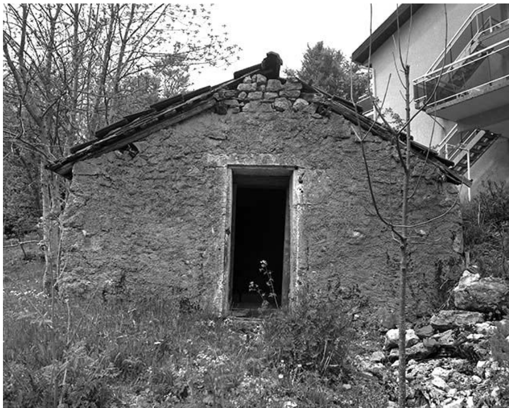
Façade antérieure de la resserre, " grenier fort ".
